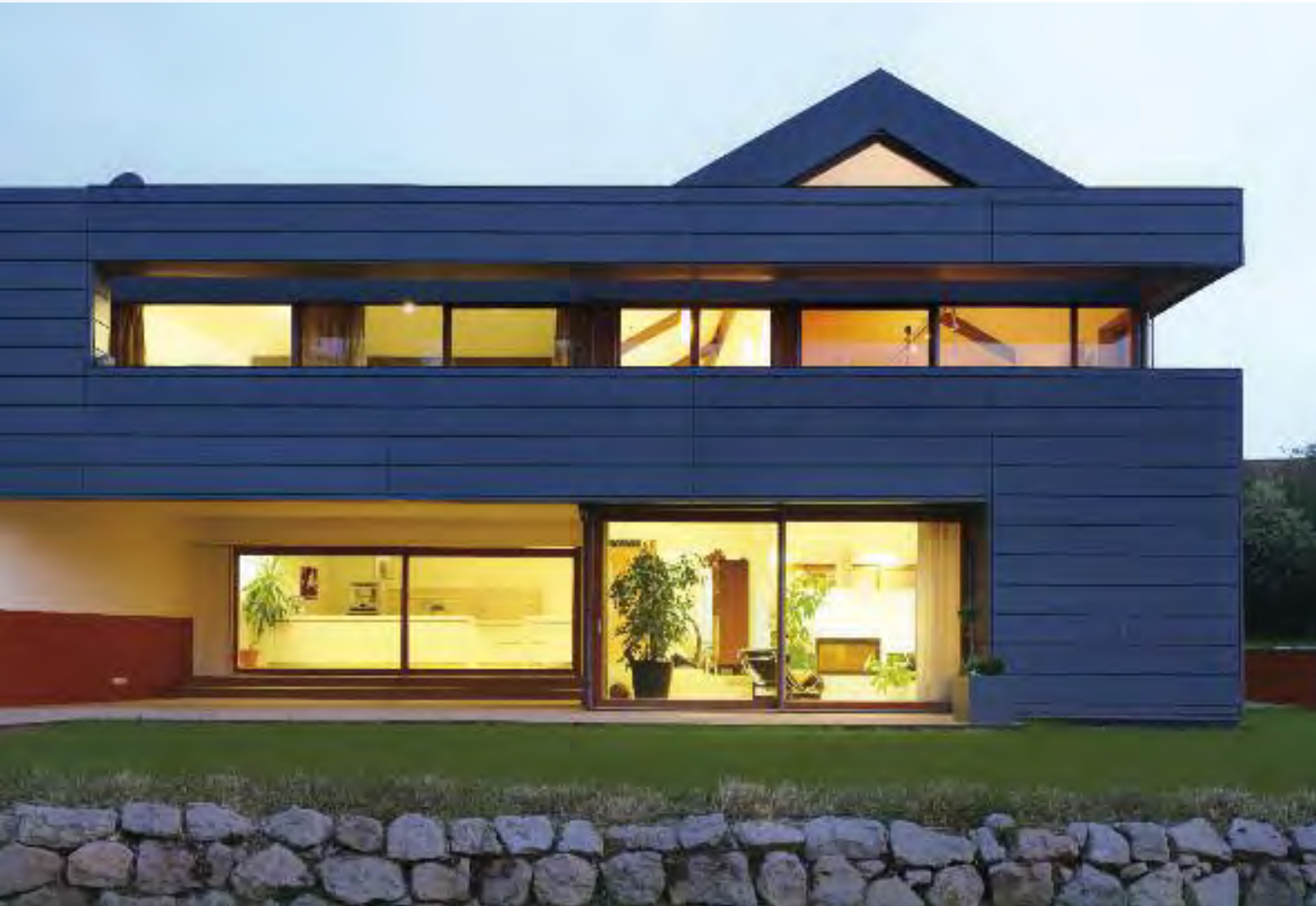
Wohnhaus | Residential building | Maison d'habitation; Cornelia Suhan, D-Dortmund
