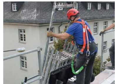
Leichtes und sicheres Entladen des Gerüstmaterials
