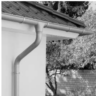
Tölcséresen kialakított függesztett betorkollóelem, egyenes kifolyású hengeres csőcsatlakozással
