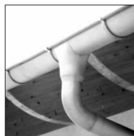
72°-os RHEINZINK®-csőívekkel kialakított hattyúnyak
