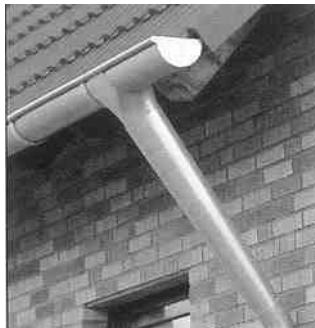
Tölcséresen kialakított függesztett betorkollóelem, 50°-ban ferde kifolyású kónikus csőcsatlakozással
